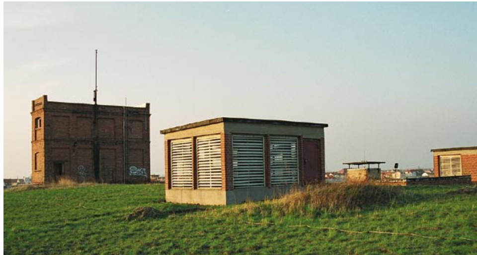
Begrüntes Dach der HALLE 14
