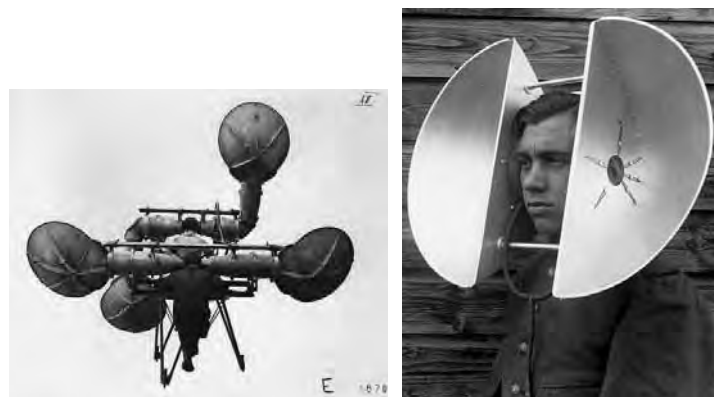
Historische Abhörapparate: Tschechisches Gerät zur Tonortung mit 4 Hörnern (aus den 1920ern) und ein Parabolreflektor der holländischen Armee (Prototyp 1 aus dem 1. Weltkrieg).
