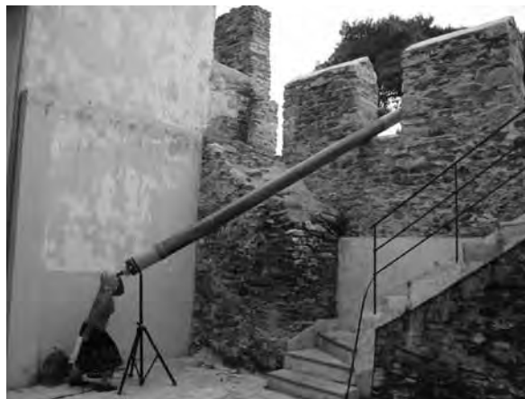
Installation eines Periscopes im ehemaligen Gefängnis Eptapyrion, Thessaloniki, 2007
